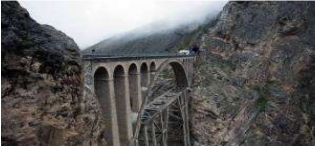
پل ورسک در دره ورسک در روستای ورسک، واقع در ۴۵ کیلومتری جنوب شهر زیرآب و ۸۵ کیلومتری شهر قائم شهر در محور فیروزکوه و در مسیر راه آهن شمال قرار دارد.
